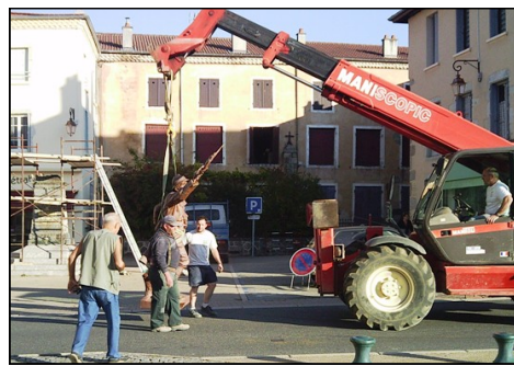
Traversée de route
